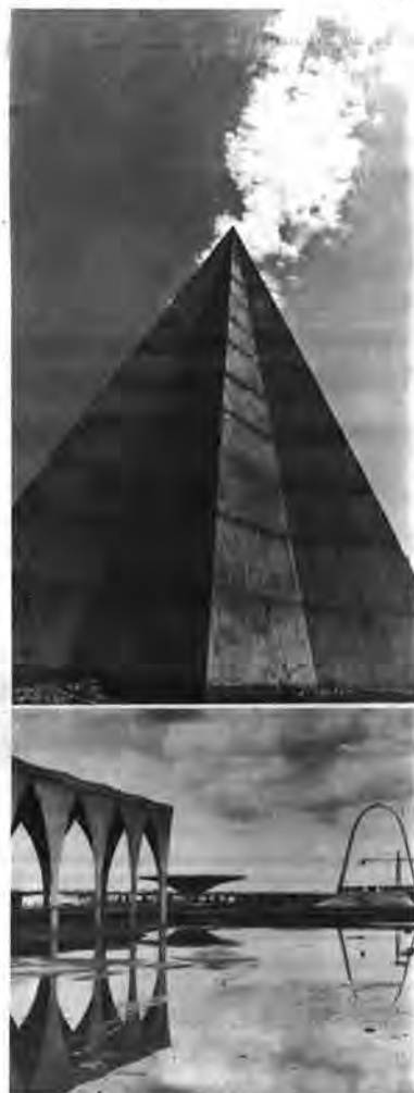
Une tente de béton armé, sans autre couverture que la porte d'entrée, abritera le manège destiné aux enfants (photo du haut). Se mirant dans l'étang aux crapauds (photo du bas), le pavillon libanais, entouré d'arcades. Au deuxième plan l'héliport et le portique d'entrée. Tout à fait à l'arrière, la masse du pavillon des Nations.
